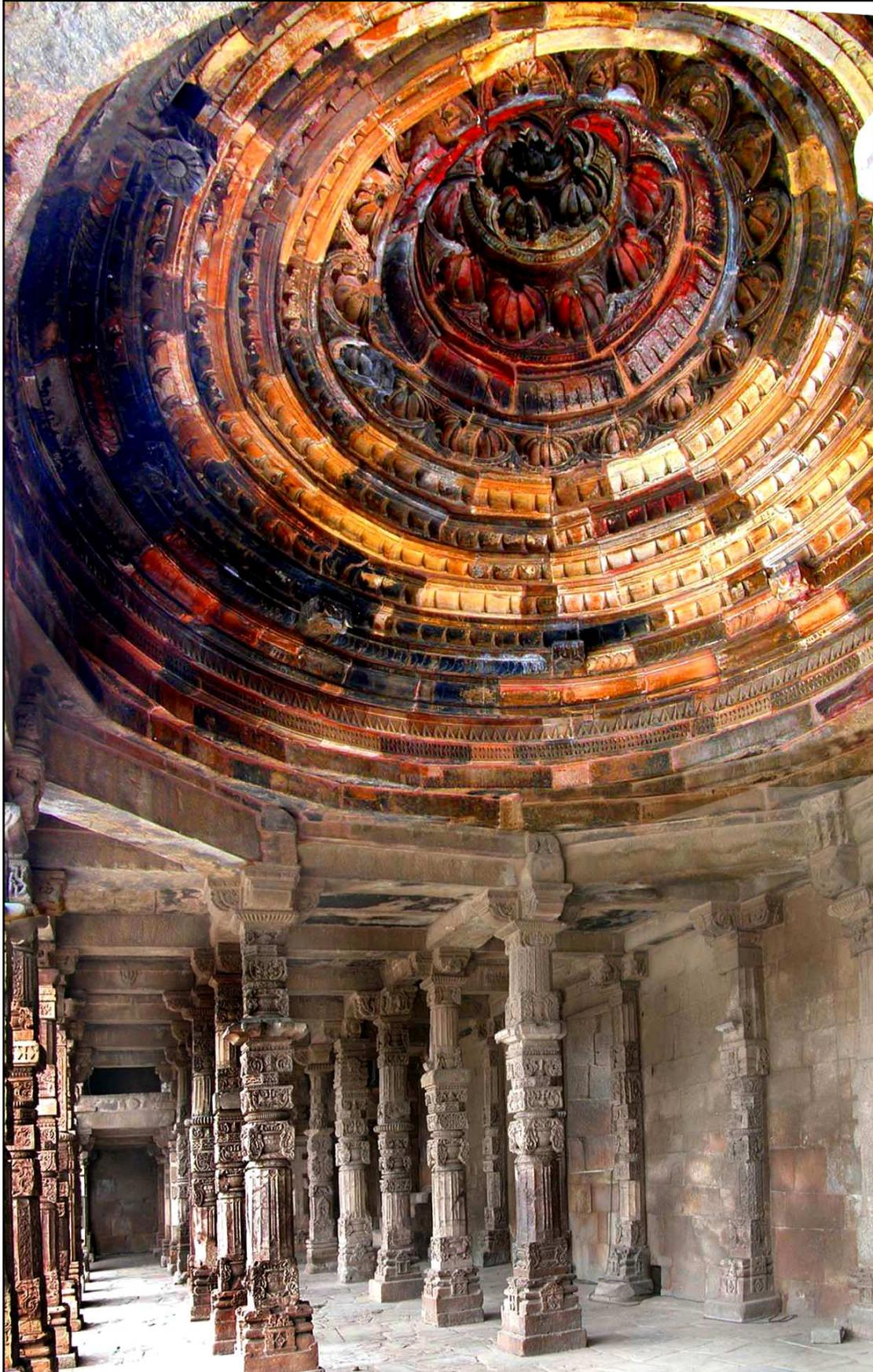
*Système de construction des temples hindouistes avec les piliers soutenant les linteaux qui eux-mêmes supportent le plafond fait de panneaux de pierre. La coupole est formée de linteaux de pierre empilés en encorbellement et se rétrécissant dans les hauteurs. Qutb Minar de Delhi.*
