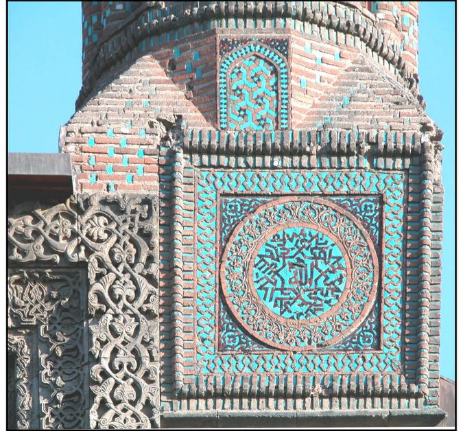
*La transition entre le fût des minarets formé de colonnes de briques rouges et les frises de tuf volcanique du portail s'effectue par un carré de kaschis turquoise.*
